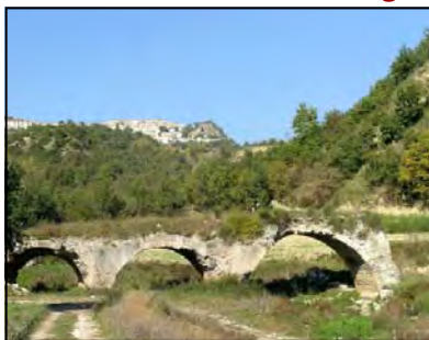
Ponte delle Chianche
